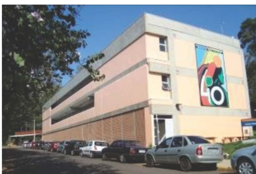
Imagens 11 e 12 - edifícios de Aulas Teóricas recentemente construídos no campus São Carlos. Possuem circulação vertical através de elevadores, atendendo à legislação de acessibilidade universal.
