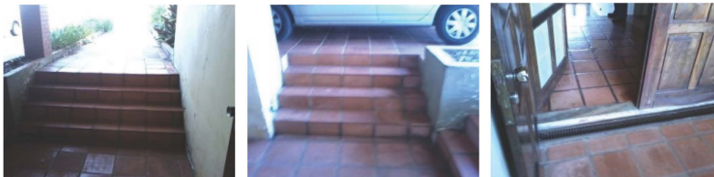
01 / 02 / 03: Prédio com vários desníveis.
