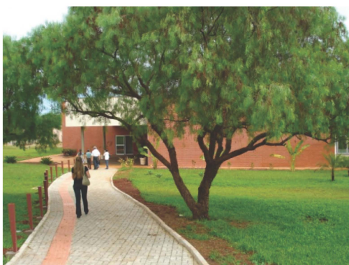
Imagem 10 - adequação de calçadas externas do campus Araras: instalação de pisos táteis.
