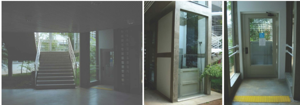
Plataforma para PNE; Piso podotátil de alerta
