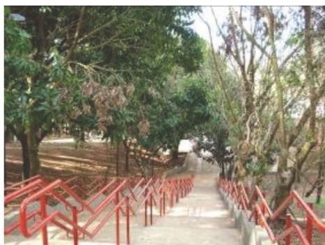
Imagem 07 - adequação de escadas externas de acesso ao Restaurante Universitário, no campus São Carlos: instalação de corrimão e pisos táteis.
