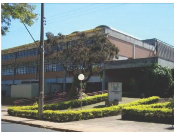
imagem 06 - edifício da Biblioteca Comunitária localizado no campus São Carlos, datado de 1994 e projetado com acessibilidade total através de rampas internas e externas.
