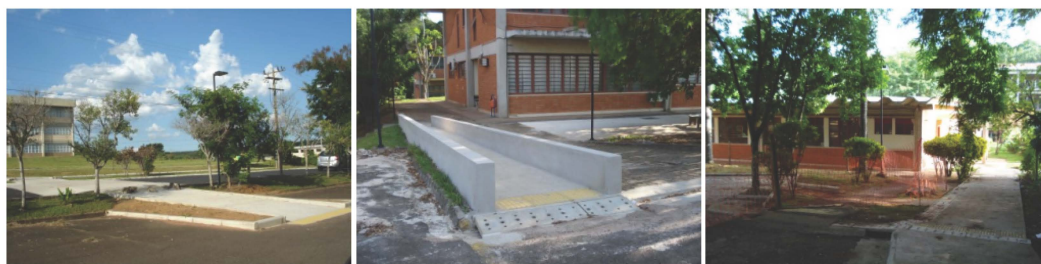
Passagem elevada; Rampa de acesso ao prédio; Vagas para PNE
