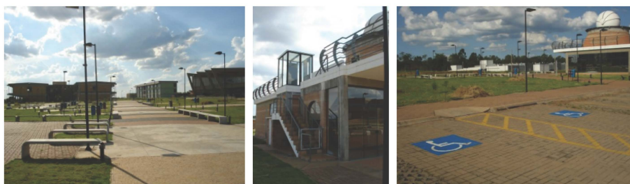
Calçada em nível; Manutenção da plataforma; Vagas para PNE
