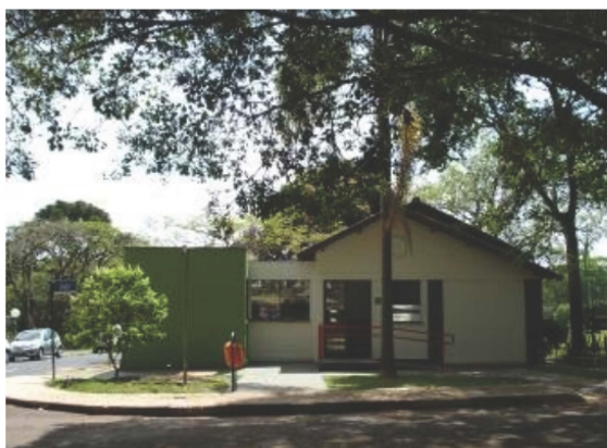
imagem 05 - edifício no campus São Carlos, que abriga o Departamento de Registro de Diplomas, datado de 1960, que em 2007 passou por reforma e ampliação para adequação à acessibilidade e criação de sanitários adaptados.
